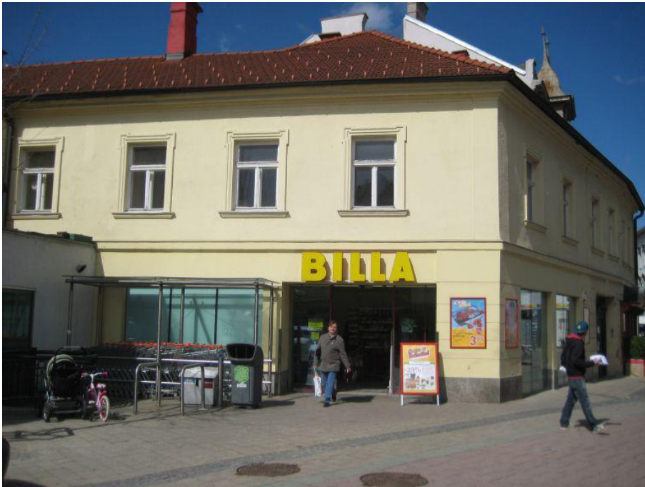
Abbildung 1.3.4.1: Bestehender "Billa"-Lebensmittelmarkt an der Adresse Wassergasse 14
